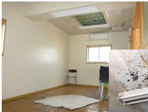
雨漏れにより内装が破損
