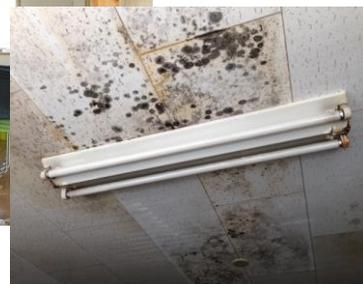
事後保全 屋上防水からの漏水に伴った内装の破損
